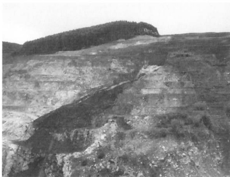
Figure 4 Foto dos Escorregamentos de Solo
